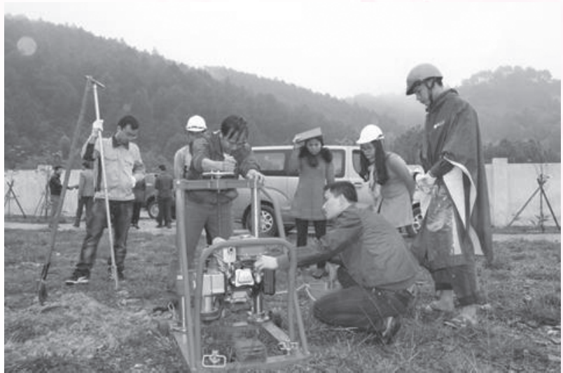
Khoan thử địa chất tại bãi chôn lấp; Ảnh PC
