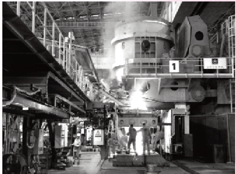
Một góc nhà máy luyện thép Formosa Hà Tĩnh; Ảnh: PV
