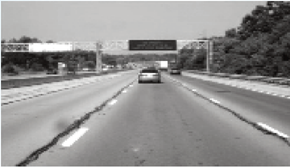
Hình 1: Lớp phủ mặt đường cao tốc phủ lớp HMA dày 19mm chứa 39% xi thép
