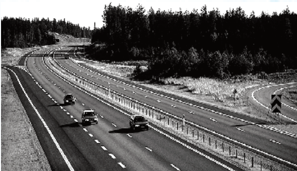
Hình 3: Đường cao tốc E4 ở phía nam Nyköping ở Thụy Điển sử dụng xi lò cao
