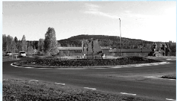
Hình 4: Vòng xuyến sử dụng bê tông nhựa đường xi thép ở Smedjebacken, Thụy Điển
