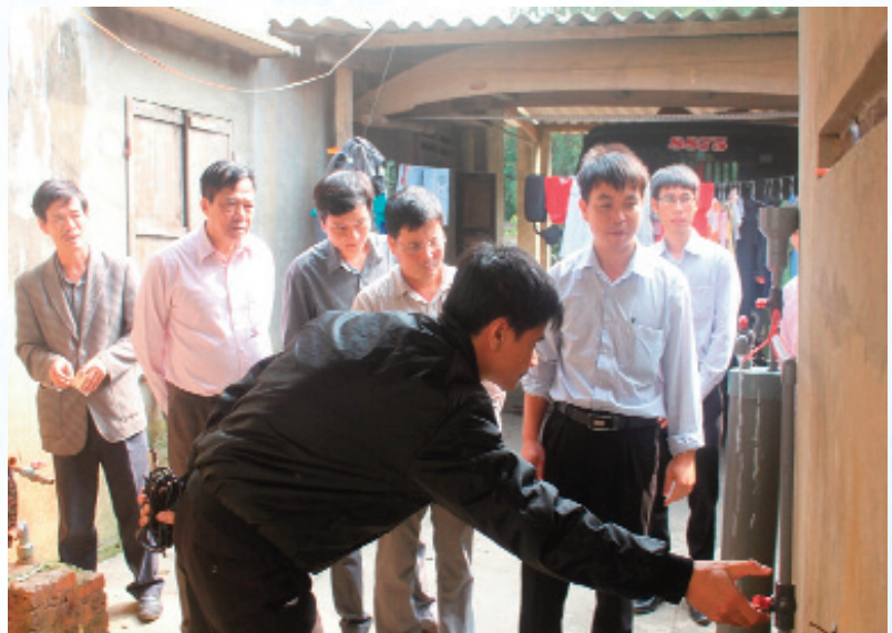
Lắp đặt thiết bị tại xã Đức Châu (Đức Thọ)
