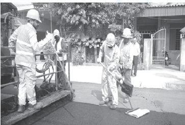
Công nghệ lớp phủ Micro Surfacing tuyến đường Phú - Tân Xuân
