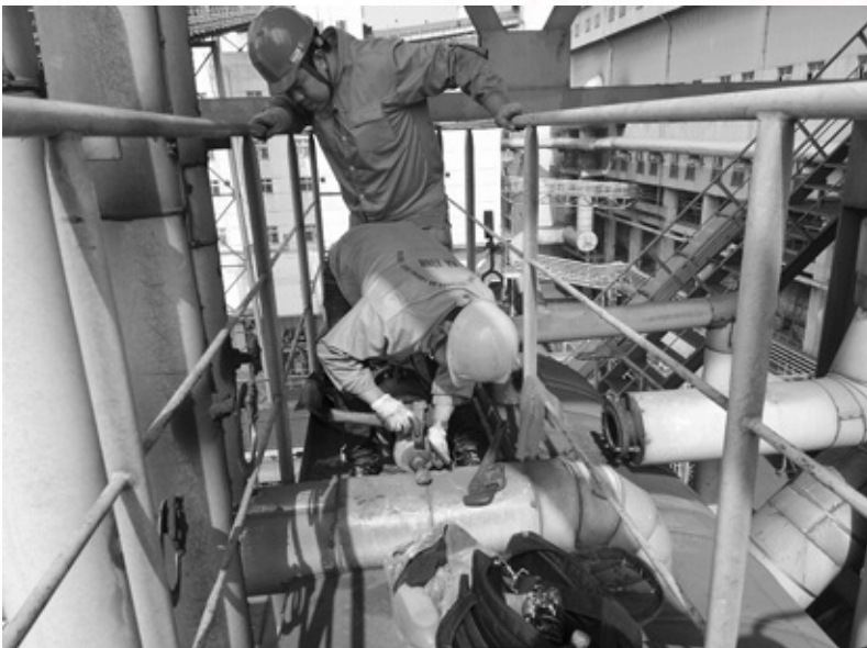
Cán bộ kỹ thuật Trung tâm Kỹ thuật Tiêu chuẩn Đo lường Chất lượng - Bảo trì, bảo dưỡng van an toàn tại Công ty TNHH Gang thép Hưng Nghiệp Formosa Hà Tĩnh; Ảnh: PV
