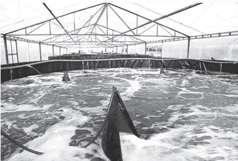
Nhà kính ương dưỡng tôm với hệ thống sục khí, điều hòa nhiệt độ nước áp dụng công nghệ cao thuộc Công ty TNHH Sao Đại Dương ở xã Thạch Trị (Thạch Hà - Hà Tĩnh) vừa đầu tư hơn 14 tỷ đồng xây dựng nhà kính ương, dưỡng tôm công nghệ cao và hệ thống xử lý nguồn nước. Ảnh: PV
