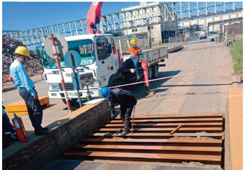
Cán bộ Trung tâm thực hiện dịch vụ bảo dưỡng cân ô tô và van an toàn tại xưởng Formosa; Ảnh: P.V
