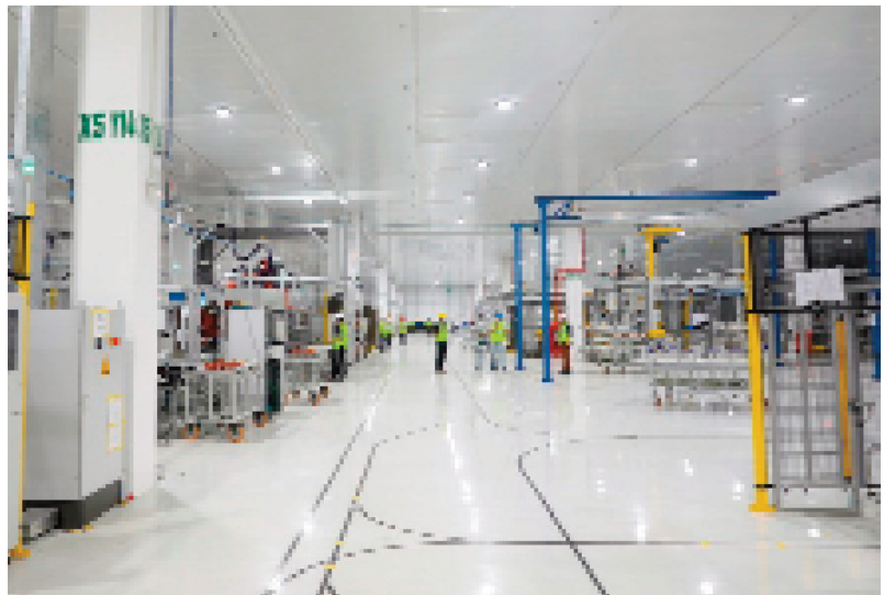
Bên trong Nhà máy sản xuất pin VINES Vũng Áng; Ảnh: PV
