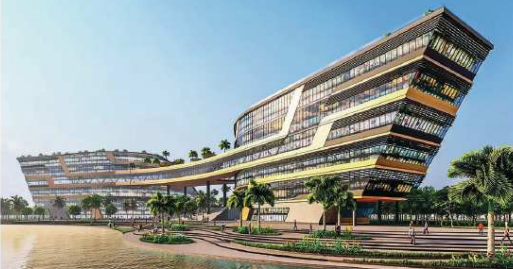
Trung tâm Đổi mới sáng tạo Quốc gia tọa lạc tại Khu Công nghệ cao Hòa Lạc đã được khởi công xây dựng ngày 09/01/2021.
